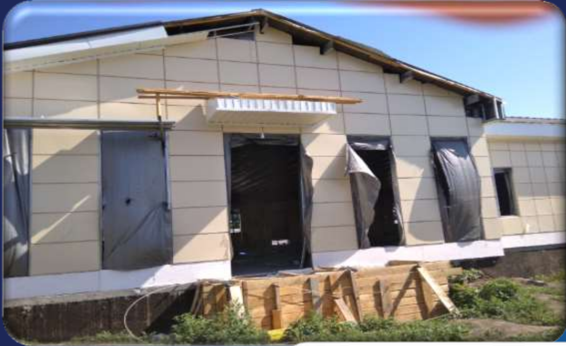
Будівництво Слов'янської амбулаторії
