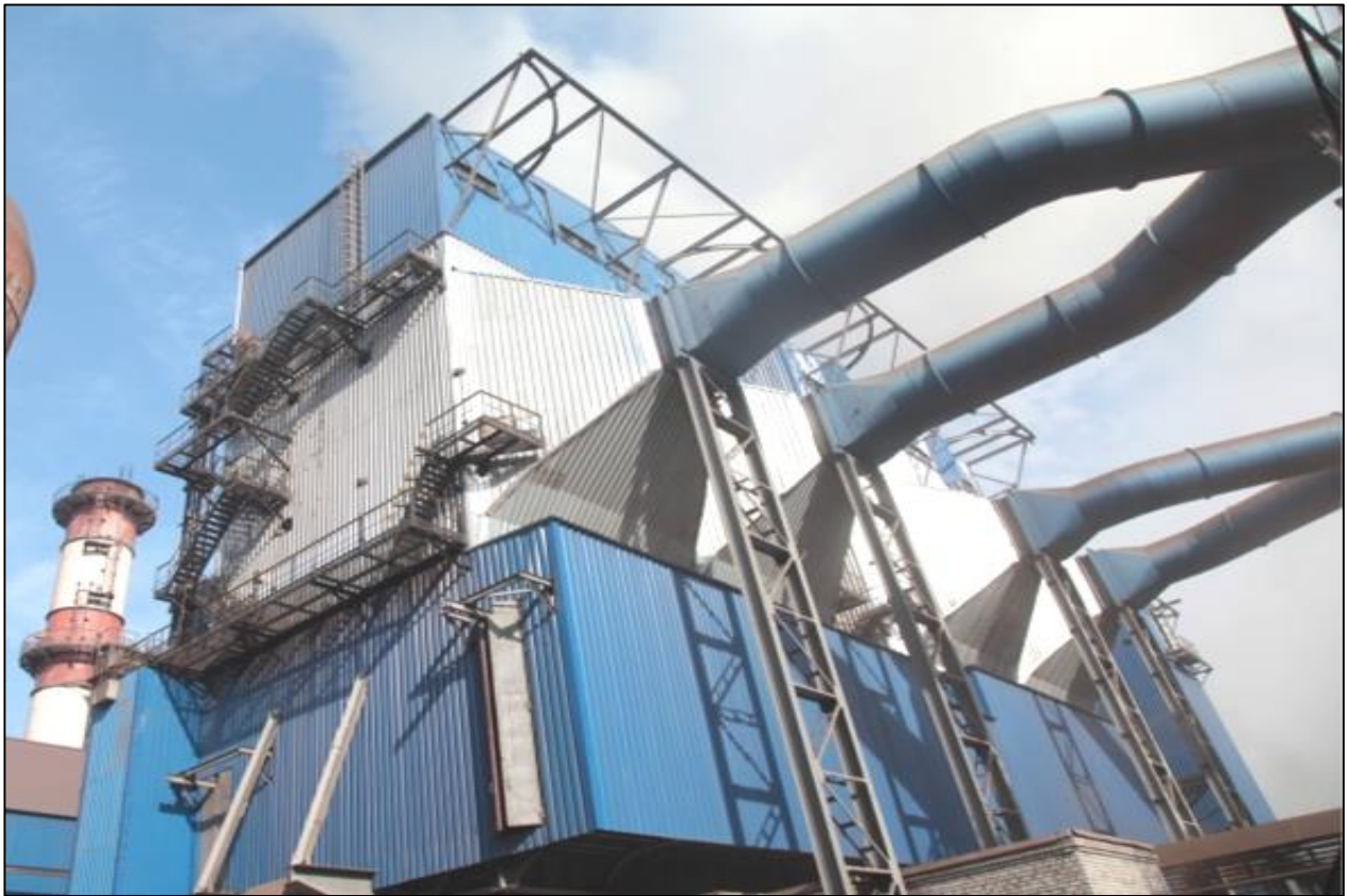
Фото 6.3 ПАТ “АрселорМіттал Кривий Ріг” ДЦ-1. Доменна піч №6. Будівництво установок очистки газу від ливарного двору та підбункерного приміщення. Електрофільтр від ливарного двору.
