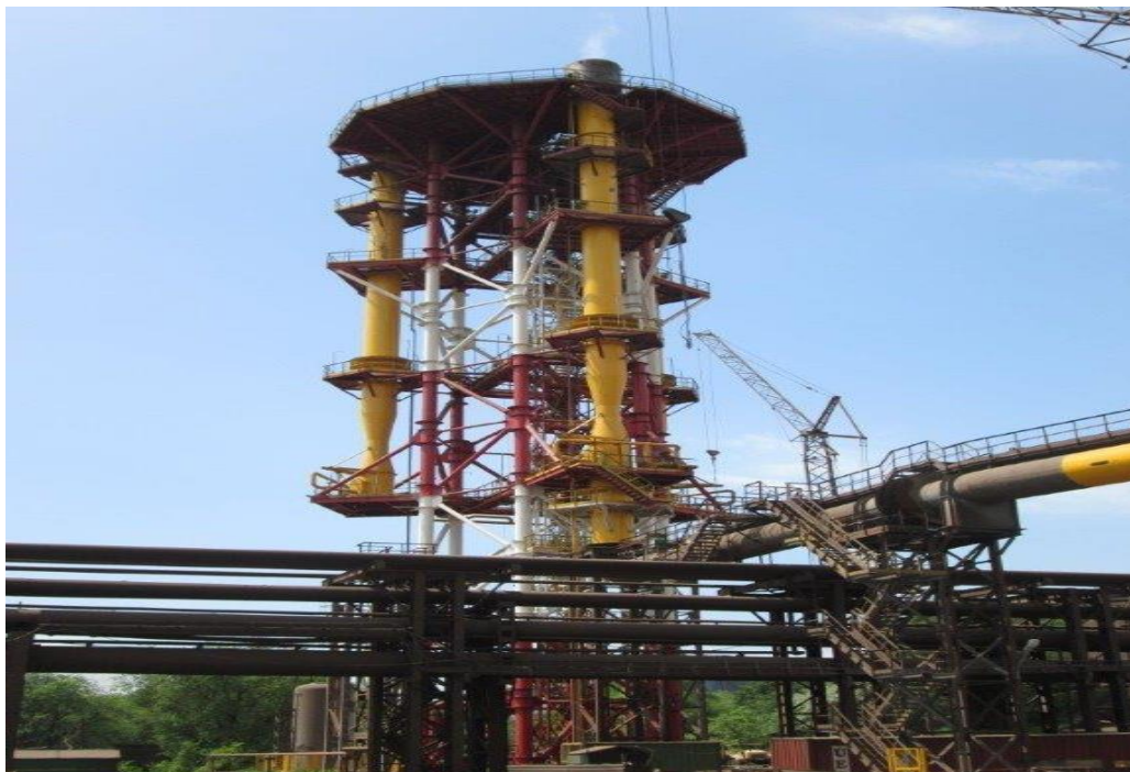
Фото 6.4. ПАТ “АрселорМіттал Кривий Ріг”. Конвертерний цех. Будівництво нових ГОУ від конвертерів №№5,6.
