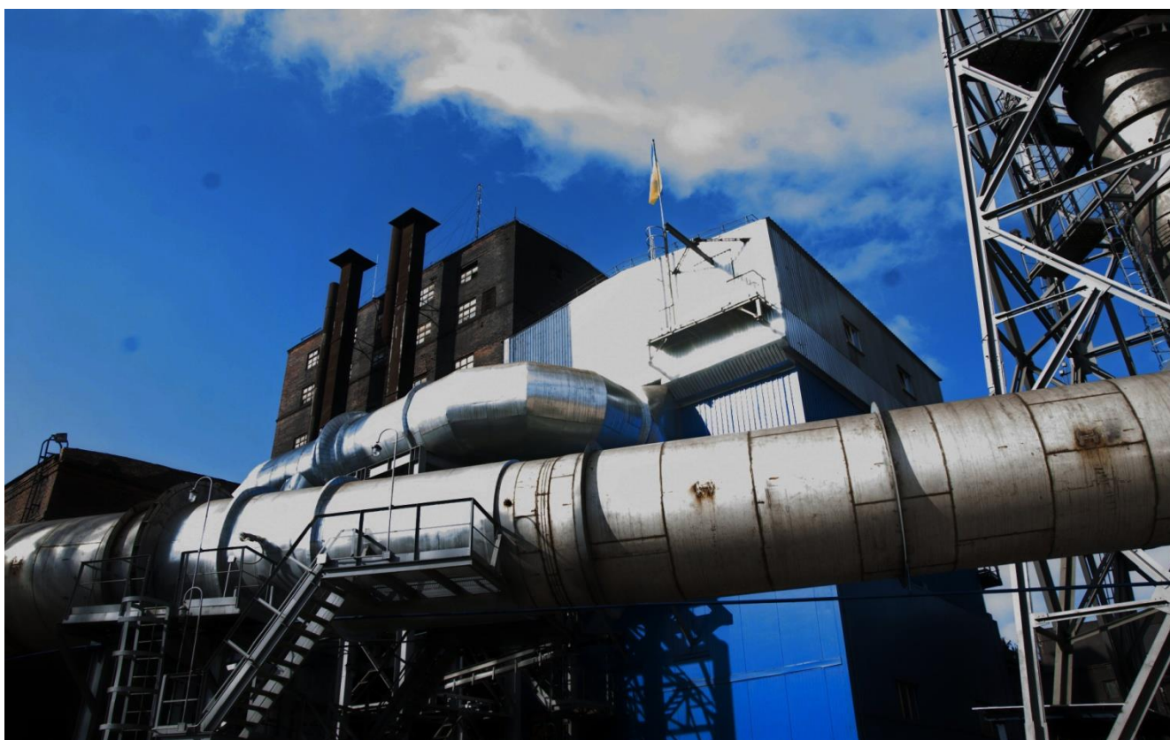
Фото 6.2. ПАТ “Орджонікідзевський гірничо-збагачувальний комбінат”. Впровадження пилогазоочисних установок на базі рукавних фільтрів з імпульсною регенерацією з очистки газопилового потоку від агломераційної машини Богданівської збагачувально-агломераційної фабрики.
