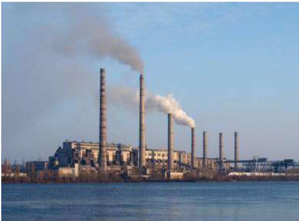
Фото 5.1. ВП “Придніпровська ТЕС” ПАТ “ДТЕК Дніпроенерго”
